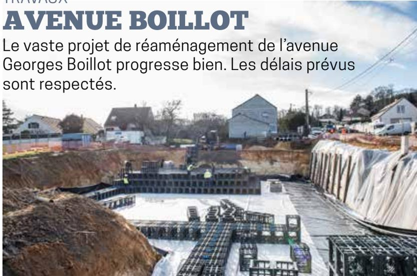
Les travaux liés aux réseaux sont quasiment terminés. Le bassin de récupération des eaux pluviales (en photo ici) est désormais rebouché.
